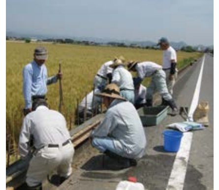
自主施工による水路の補修
