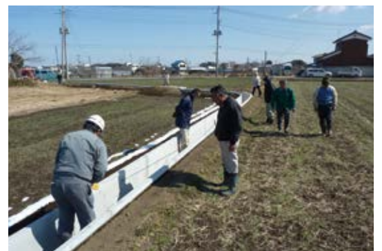
更新した水路の完成検査を行う
