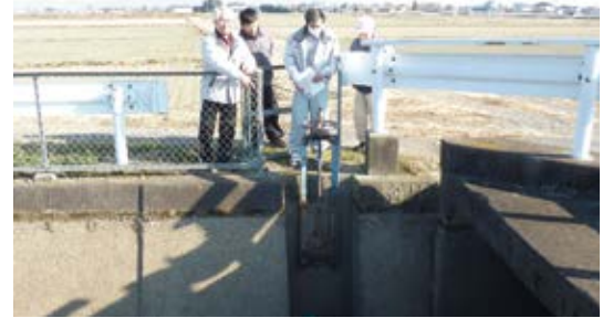
水路のゲート更新の前に業者と現地で確認を行う
